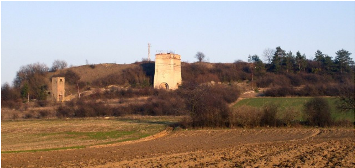
Kamienna Góra, piec wapienniczy. Widok na „górne” lotnisko. Stan obecny, widok od strony zachodniej. (Fot. ze zb. własnych)
