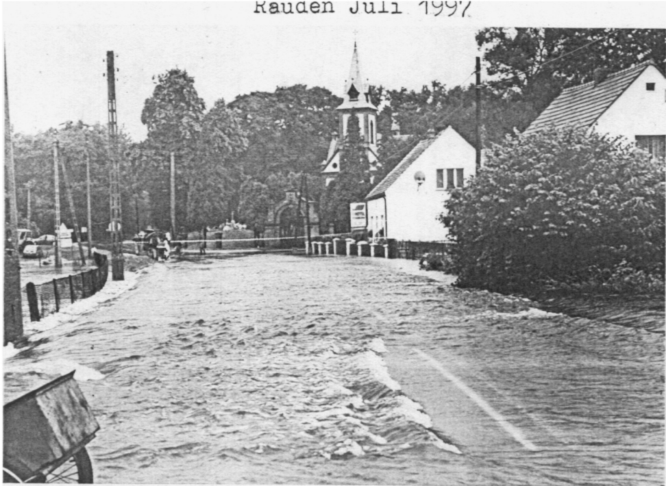
Überflutete ehem. Dorfstr. jetzt J. Rogerstr.
