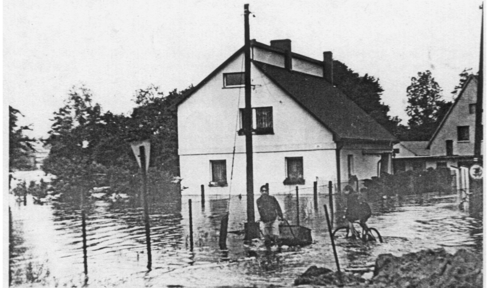
Überschwemmte Kurze Straße
