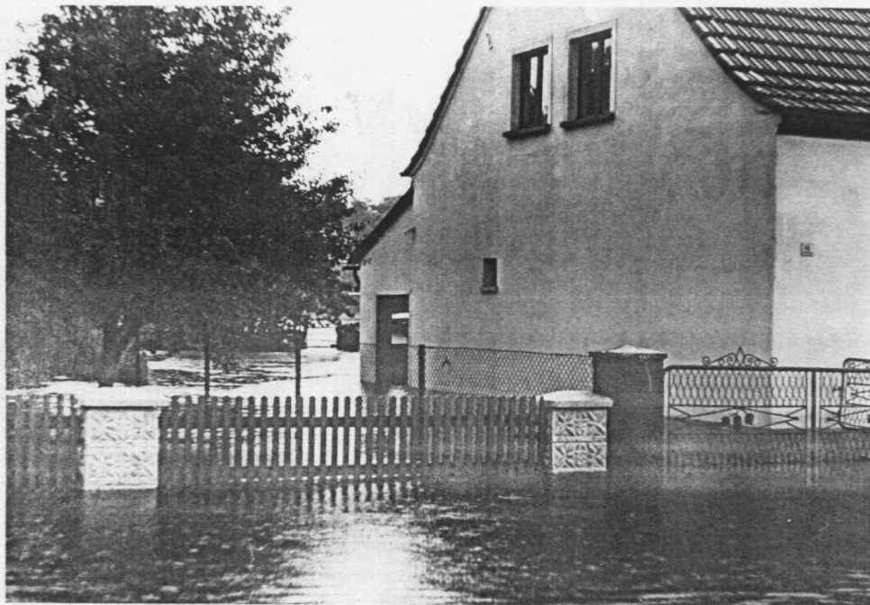
Überschwemmte Wohnhäuser an der J. Rogerstr.
